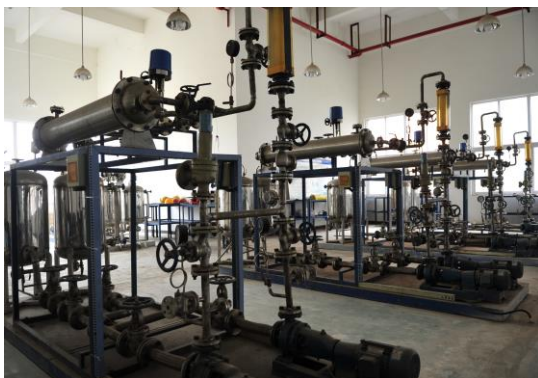
化工管路拆装室
